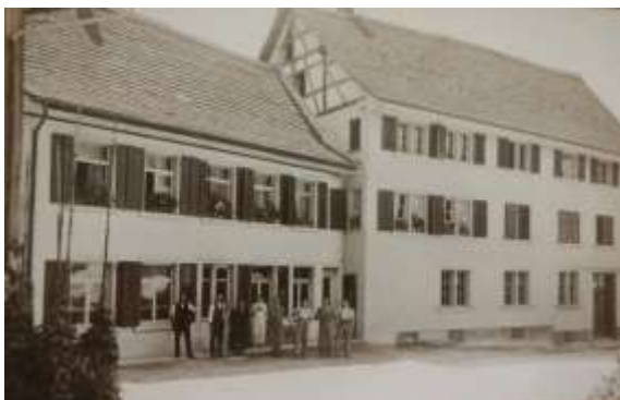
Abb. 96b 1920er Jahre; nach Umbau
