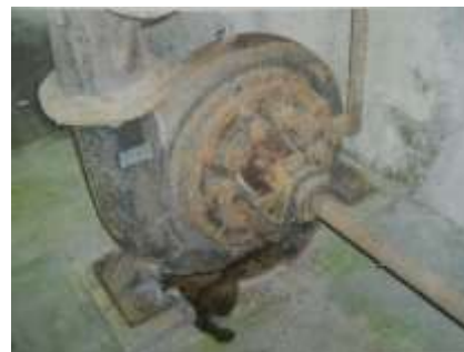
Abb. 179 Bericht Abb. 1: Francis-Spiral-Turbine von Gottl. Giezendanner, Oberuzwil, 1941
