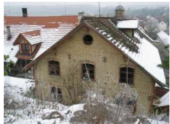
Abb. 130 28.11.2008; von oben auf Mühlengebäude
