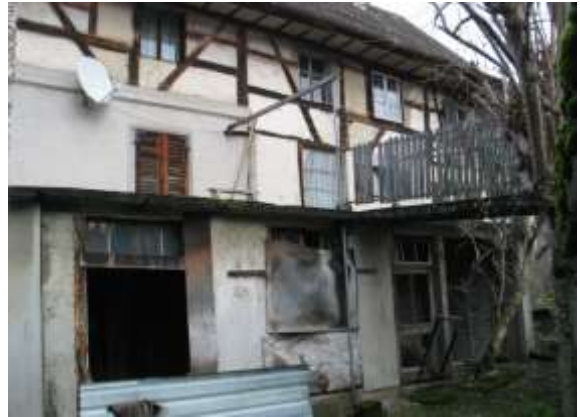
Abb. 107 2.12.2008; Im Raum unten befand sich das Mühlrad
