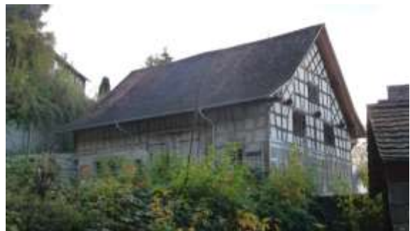
Abb. 136 5.11.2009; Scheune mit neuem Dach 110
