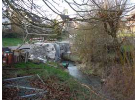
Abb. 173 25.1.2012; Durchlass zum Wildbach von Süden
