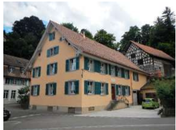
Abb. 170 27.6.2017 Nach umfassender Aussenrenovation
