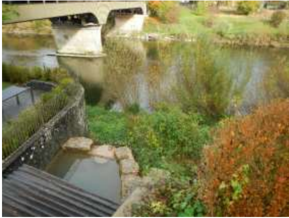
Abb. 17 2.11.2013; an der Thurbrücke
