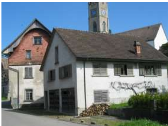
Abb. 116 3.5.2008; nie als Wohnhaus benutzt; Parterre als Holzlager / Verarbeitung benutzt 94
