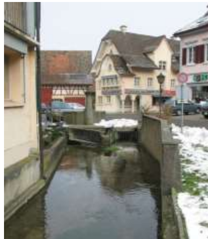
Abb. 14 26.11.2008; Trennung der Wassermenge am Marktplatz; 3/5 für Linden-, Stein- und Untermühle; 2/5 fließen gegen das Schloss zu, um dort in eine Druckleitung aus 35 m Höhe hinterzufallen.
