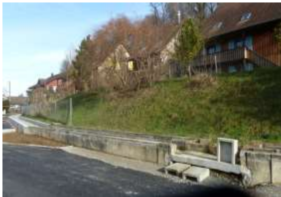
Abb. 177 31.1.2013; der Kanal zur Obermühle
