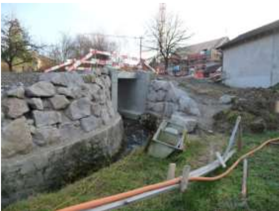
Abb. 172 25.1.2012; Durchlass zum Wildbach von Norden
