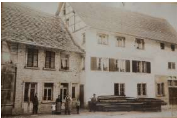
Abb. 96a 1901; vor Umbau
