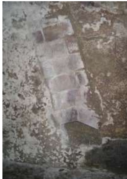
Abb. 65 28.8.2009; Aschekanal von der ehemaligen Backstube in den Keller
