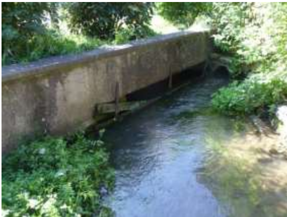
Abb. 11 20.7.2009; Ausflussrohr der Obermühle
