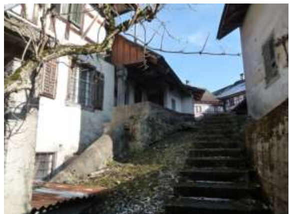
Abb. 109 3.2.2009; Blick auf die Wasserröhre zum nicht mehr existierenden Mühlrad
