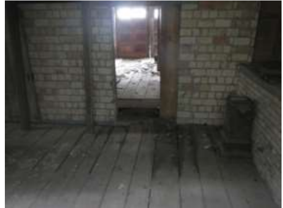
Abb. 118 19.8.2014; Blick von hinten durch das Nebengebäude
