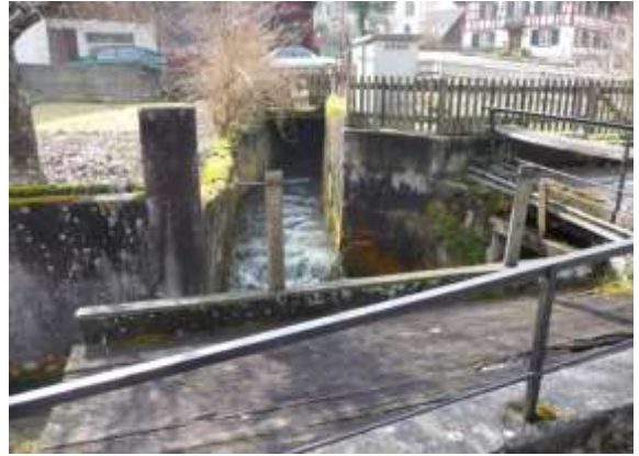
Abb. 20 7.3.2009; Wildbach-Tunnel (Mitte) am Zusammenfluss mit dem Mülibach
