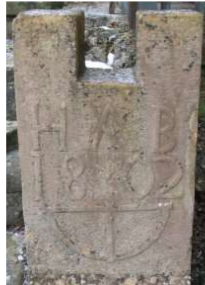
Abb. 81 26.11.2008; Bietsstein 75 = Sockelstein, der den Mahlboden trug. Oben Aussparung für einen Querträger sichtbar. Auf den Querträgern über den Sockelsteinen lagen jeweils zwei Längsträger, auf denen die Bretter des Mahlbodens aufgenagelt waren. Ein Mahlgang verfügte über zwei vordere und zwei hintere Bietsäulen; eine der vorderen war häufig mit Initialen und Jahrzahl verziert.
