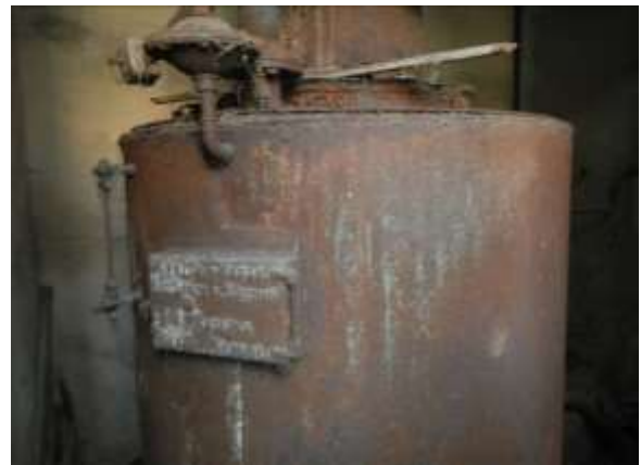
Abb. 119 6.12.2015; «Spezial-Kessel für Späne u Sägmehl [...] Roniger Basel Schweiz» im separaten Raum hinten zwischen den beiden Gebäuden
