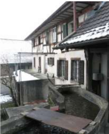
Abb. 105 28.11.2008; Kanal von der Steinmühle
