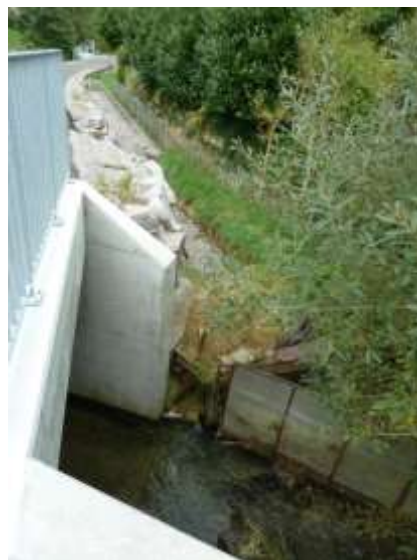
Abb. 178 19.9.2013; trocken gelegter Kanal bei der Abzweigung
