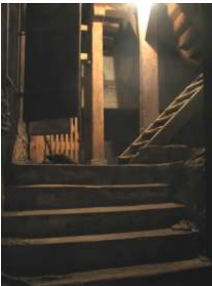
Abb. 68 28.8.2009; Treppe zum Gewölbekeller. Erkennbar, dass das Gebäude auf dem Untergrund aus Tuffstein steht
