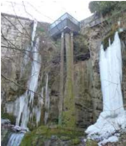
Abb. 149 3.2.2009; Wasserkanal zur Neumühle
