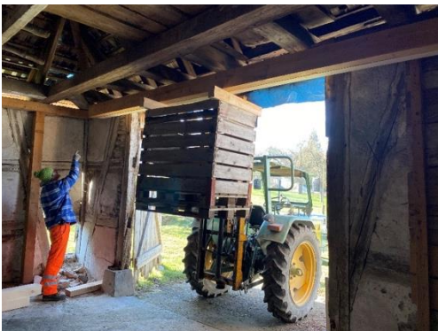
Einpassen des neuen Eingangsträgers mit Traktorenunterstützung
