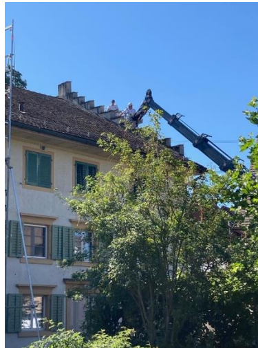
Neubelegung des Treppengiebels mit Biberschwanzziegeln
