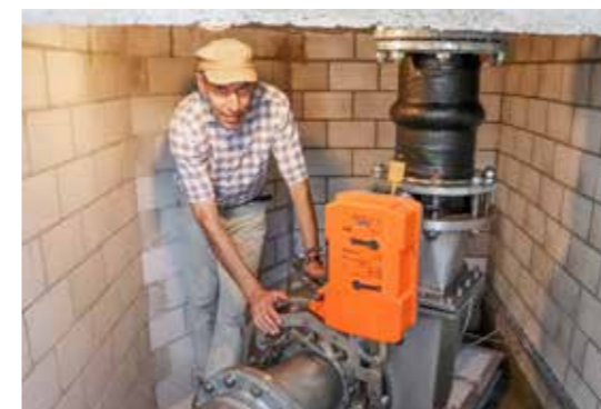
Peter Eichenberger umfasst das Gehäuse, die Turbine und Leitapparat enthält. Bild: Benedikt Vogel
