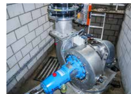
Im PaT-Francis-Projekt wird eine Abwasserpumpe als Francis-Turbine genutzt. Dieser Turbinentyp eignet sich für Wasserkraftwerke mit wenig Leistung und geringer Fallhöhe. Bild: Hydro Engineering
